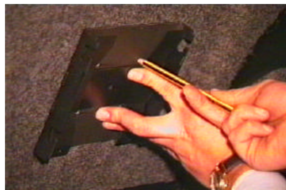
Abb. 10: Mit dem Verstärker-unterteil werden die befestigungs-bohrlöcher markiert.
